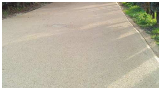
Finitura con pavimentazione stabilizzata
